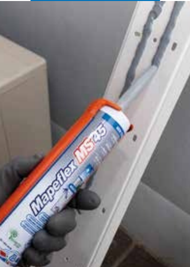
Encolado de perfiles de plástico en exteriores
