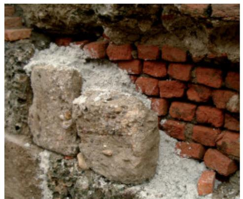
Reconstrucción de un muro con un mortero confeccionado en obra
